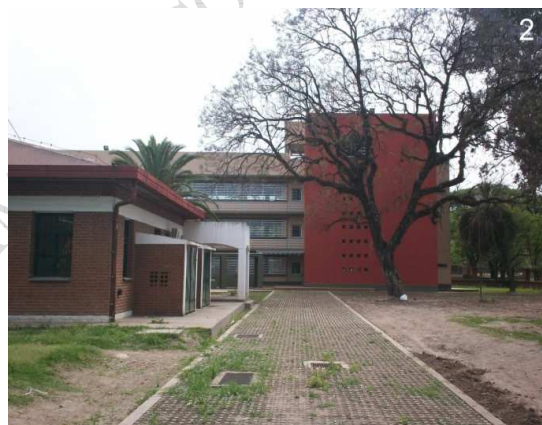
2: Camino desde la calle hacia el Pabellón de Odontología.
