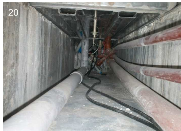
19 y 20: Vista de los plenos horizontales de servicios a los boxes odontológicos y detalle de sus conductos.
