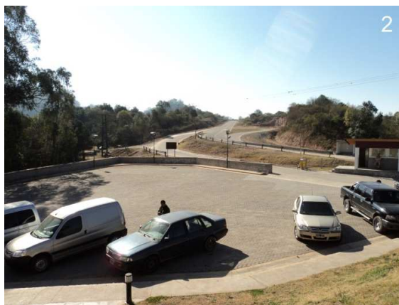
2: Vista del camino de acceso a la playa de estacionamiento, desde su inicio en la ruta provincial. Corresponde al diseño del Acceso a la Residencia Universitaria adecuado a las normas UZOVI.
