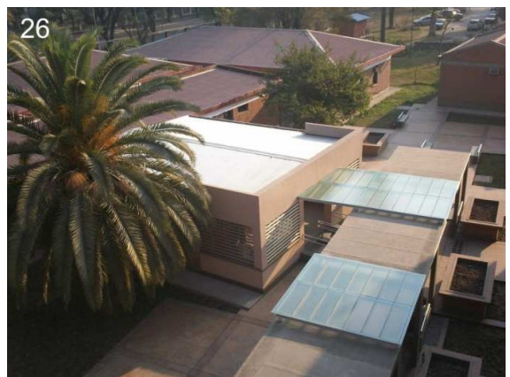
26: Vista desde lo alto del Pabellón Odontológico al Módulo de Esterilización.
