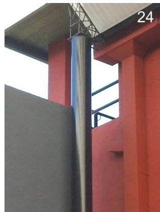
23 a 25: Detalle del encuentro del techo del Pabellón con el techo del conector, donde este último se encuentra debajo de nivel del dintel de las ventanas.
