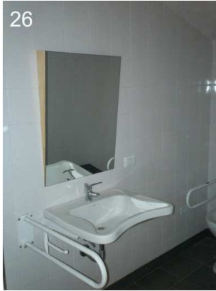
26: Vista de un sanitario para discapacitados bien resuelto. Detalle lavatorio, barral y espejo.
