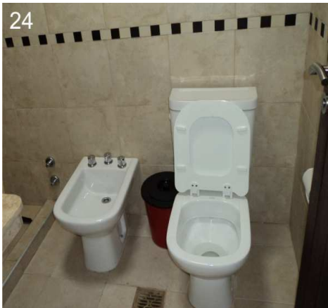
24: Refacción integral del baño.
