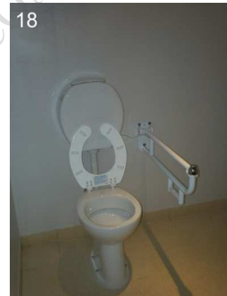
18: Sanitario para discapacitados solo con barral izquierdo.
