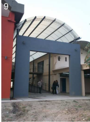
9: Vista de la nave de conexión entre las dos fachadas.
