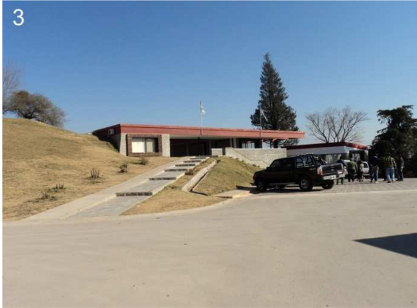
3: Vista del ingreso a la Casa 8 desde el nuevo Acceso y playa de estacionamiento.
