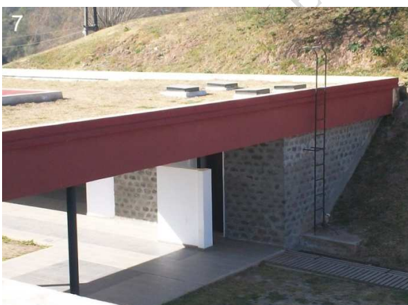
7: Se observa "Cubierta Jardín" en los techos, característica de diseño del complejo.
