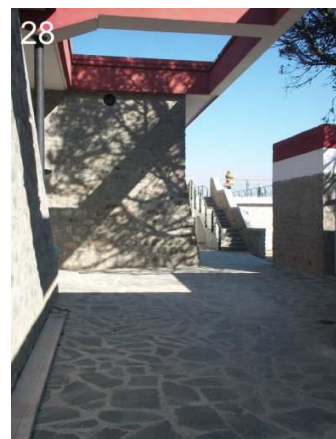
28: Vista de patio - bajo nivel de la Casa N° 8 - distribuidor a: Quincho, Salas de Reuniones, escalera a Terraza, expansión del Comedor.
