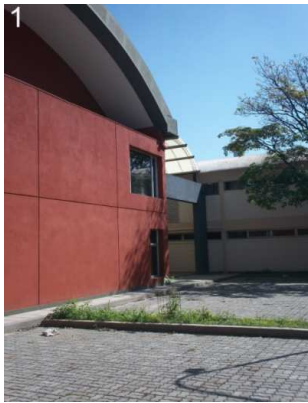
1: Vista lateral opuesta a la galería de circulación. Atrás construcciones pre-existentes.
