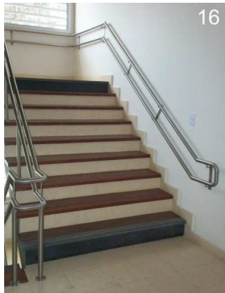
16: Vista detalle de las barandas de una de las escaleras del edificio.
