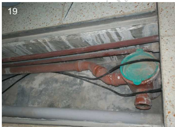
19 y 20: Vista de los plenos horizontales de servicios a los boxes odontológicos y detalle de sus conductos.
