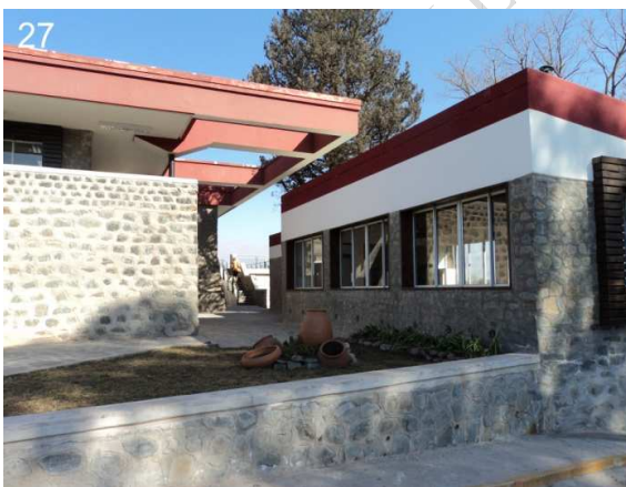
27: Vista de la casilla de Vigilancia. Una construcción nueva, respetando el estilo original de las construcciones preexistentes.
