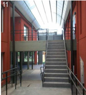
11: Vista escalera de acceso al primer piso.
