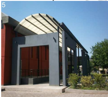
5: Vista de la nave del frente. Fachada de acceso.
