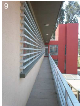
9: Pasillo exterior y detalle de las rejas y balcones.
