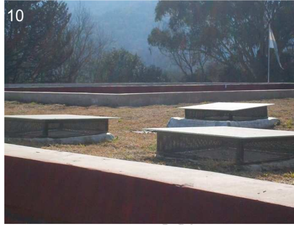
10: Detalle de respiraderos del local inferior.
