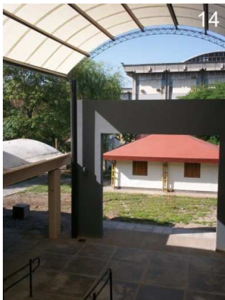
14: Detalle de conexión entre edificio nuevo y galería preexistente, desde el primer piso.
