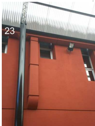
23 a 25: Detalle del encuentro del techo del Pabellón con el techo del conector, donde este último se encuentra debajo de nivel del dintel de las ventanas.
