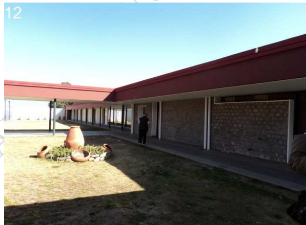
12: Vista panorámica del patio central y de los accesos a las habitaciones.
