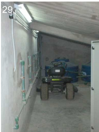
29: Vista del depósito provisto al edificio y diversos elementos técnicos y de servicios.
