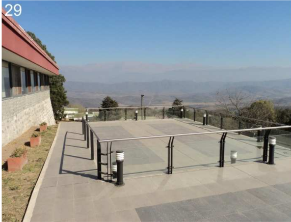
29: Terraza que resulta la expansión del Comedor con vista a los cerros.
