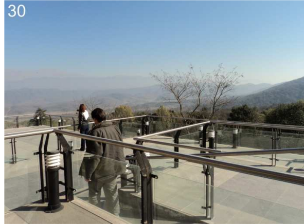
30: Detalle de las barandas de acero inoxidable y bajada.
