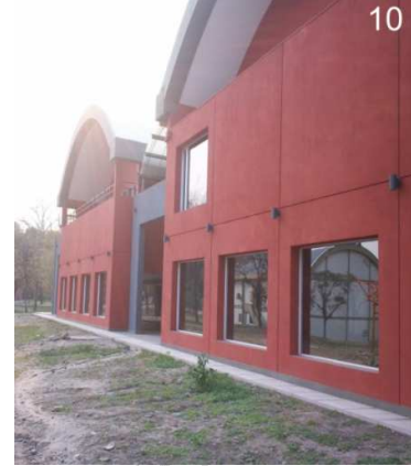
10: Vista general de esta fachada. Las amplias ventanas responden a la galería de circulación.
