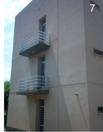
7: Vista del remate lateral del edificio.
