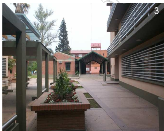
3: Vista desde el acceso del Pabellón de Odontología hacia la Facultad de Odontología de la UNT.
