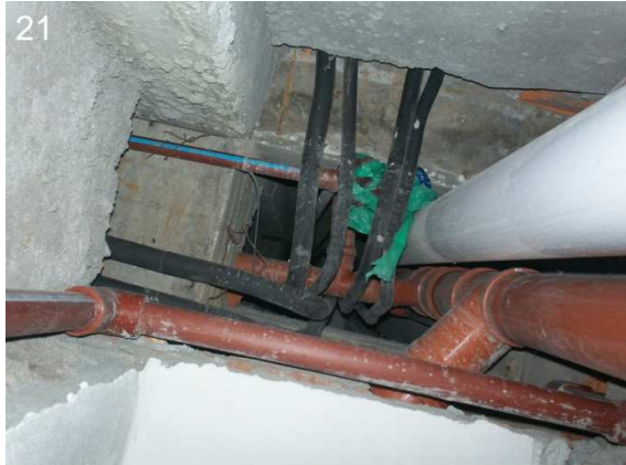
21: Vista detalle de los plenos verticales y sus empalmes horizontales.
