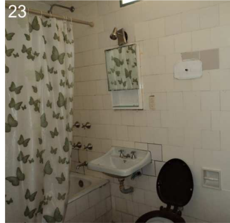
23: Baño con las instalaciones anteriores.
