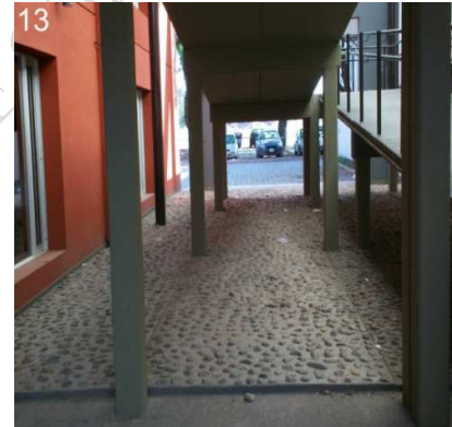
13: Vista detalle del bajo escalera con piedra bocha.
