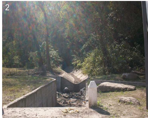
2: Detalle del canal que cruza la calzada, canal que baja de la ladera y canal paralelo a la calzada.
