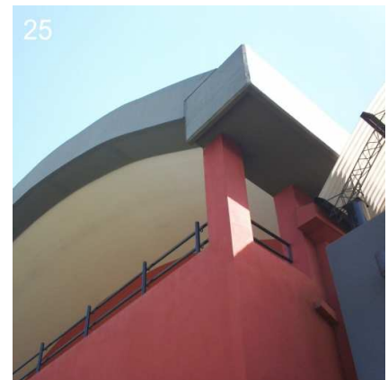
23 a 25: Detalle del encuentro del techo del Pabellón con el techo del conector, donde este último se encuentra debajo de nivel del dintel de las ventanas.
