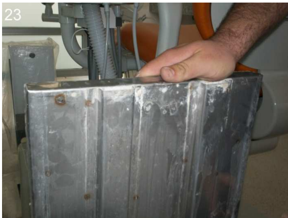
23: Tapa de acero inoxidable de los plenos en el box odontológico.
