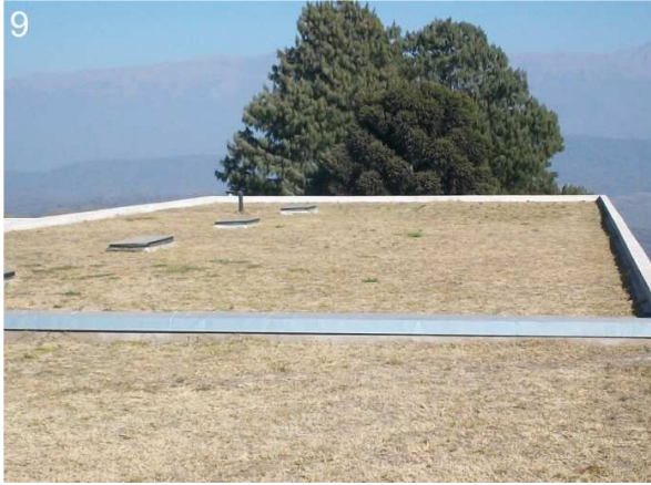
9: Techo de la planta inferior, con “Cubierta Jardín” como característica de esta obra. Respiraderos.
