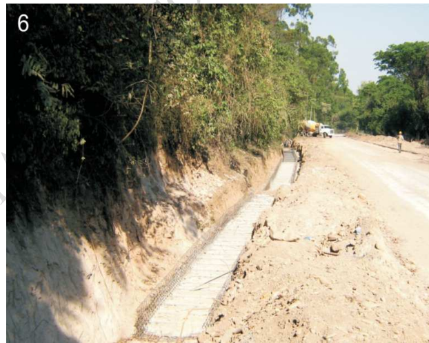
6: Detalle del canal lateral de la calzada, de mayores dimensiones.
