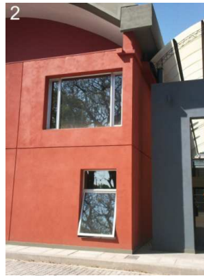
2: Continuación del lateral. Vista de las ventanas de los salones de clase.
